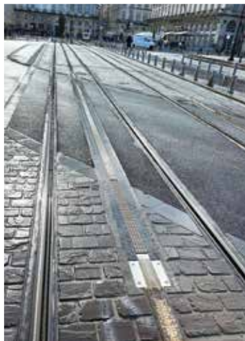
歴史的な中心地区にあるトラムの大ターミナル、カンコンス広場。A線を除く3路線が集結する。地表面から集電するシステム(APS)により、空中に架線は張られていない 2023年11月3日
