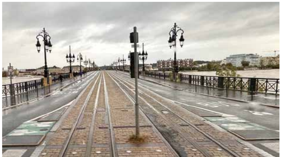
ナポレオン1世の命により、1882年に完成したボルドーで最古の橋、ボン・ド・ピエール橋(Pont de pierre)。中心部(左岸)と右岸を結ぶ全長490m、17連のアーチ石橋は2003年のトラムA線開業後、クルマの通行を排除し、トラム・バスと歩行者、自転車の専用橋になっている=2023年11月4日
