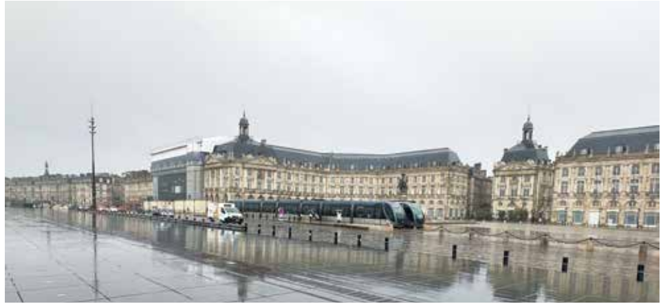
ガロンヌ川左岸の河岸開発に伴い、車道が削減されトラムの専用空間が設けられたブルス(証券取引所)広場前の道路。河岸にあった駐車場は地下化された=2023年11月4日
